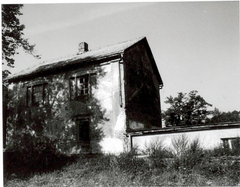
Budynek mieszkalny II od południowego-zachodu
