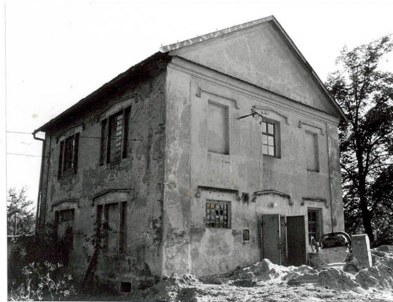
Budynek mieszkalny II od północnego-wschodu
