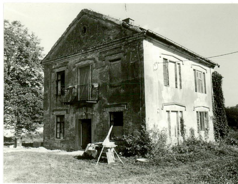
Budynek mieszkalny I od północnego-zachodu
